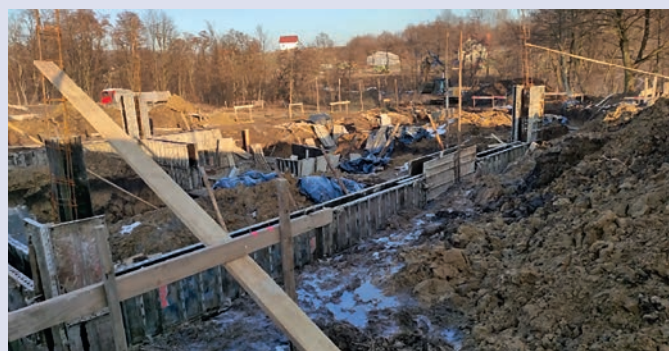
Plac budowy w Wieliczce. Rosną fundamenty.
