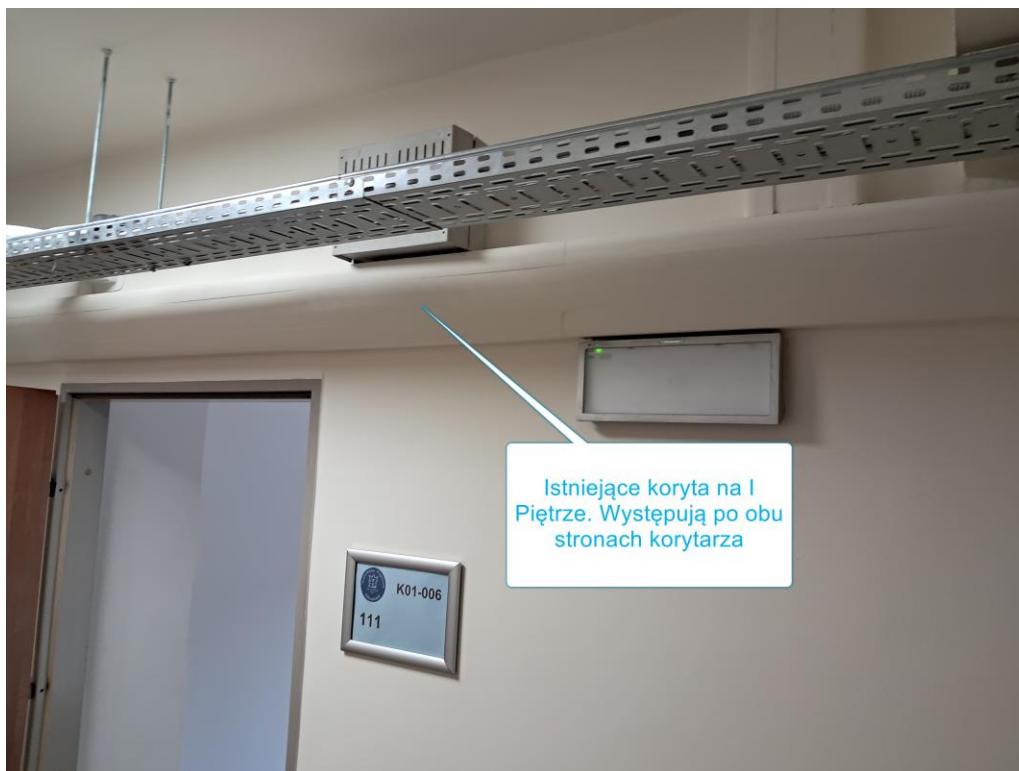
Rysunek 13 - Istniejące koryta w korytarzu na I Piętrze
