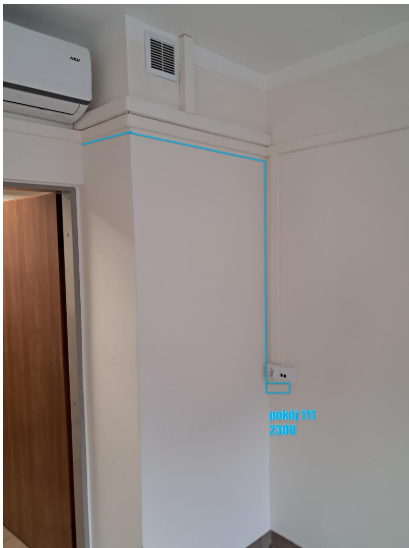
Rysunek 12 - Planowane gniazdo 230V gwarantowane w pokoju 111
