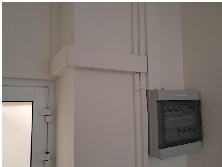
Rysunek 10 - tablica dystrybucji 230V gwarantowanego
